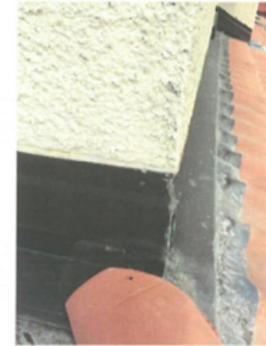
Undichte Anschlüsse
