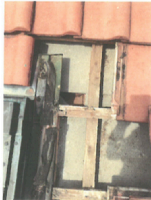
Nachträglich eingebauter Lüftungsziegel
