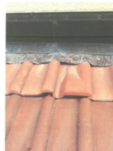
Nachträglich eingebauter Lüftungsziegel
